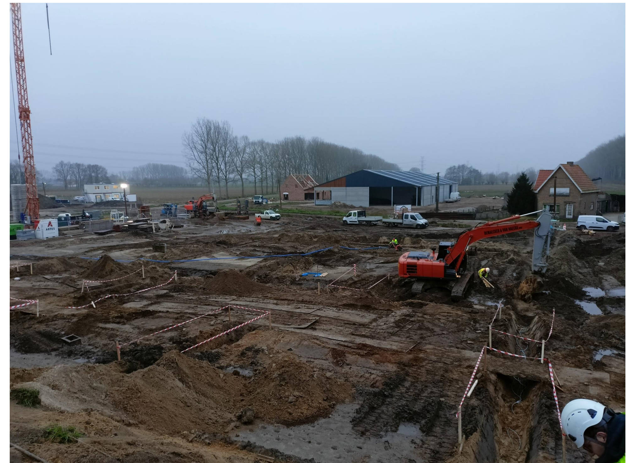
Maldegem (Belgique) (2024) – Chaque zone limitée par des rubalisees est équipée de capteurs de tassement - Dynaopt
